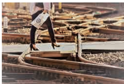
ヒール&amp;レール 東上線川越市駅構内にて
